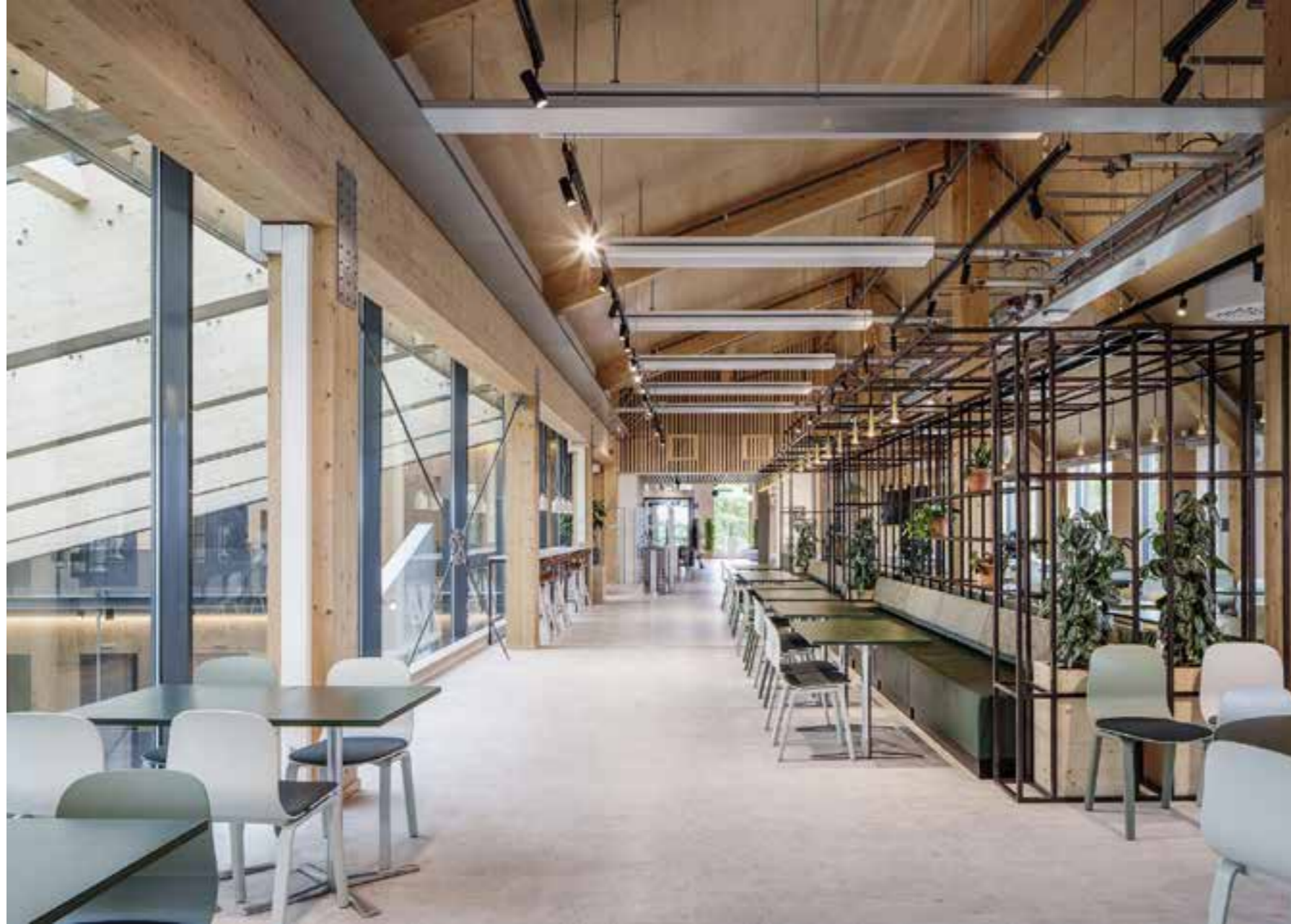
Trikåfabriken – en historisk industriell tegelbyggnad som med hjälp av innovativ timber-on-top-teknik fick en påbyggnation med trästomme i 5–7 våningar och därmed transformerades till en modern och hållbar kontorsbyggnad för 1 200 personer.
